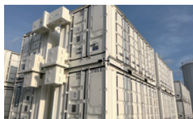
津蓄電所 (建設中)
