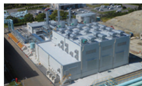
四日市発電所
